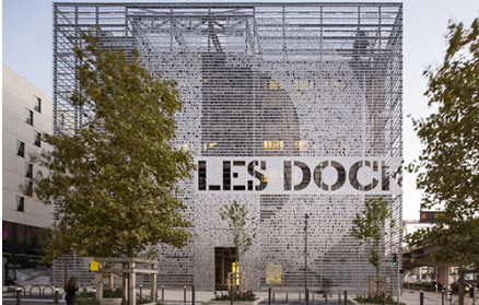
Les Docks de Marseille © Luc Boegly; Ernesta Caviola
